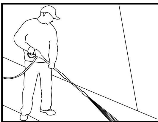
При распылении воды на очищаемую поверхность максимально эффективное воздействие достигается при лобовом контакте воды с поверхностью.
